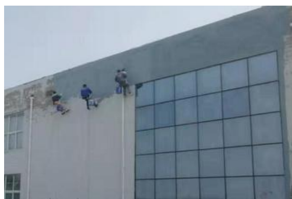
图 22：学校后勤组织车间外墙施工
